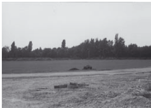
Az új pálya építésének kezdete
