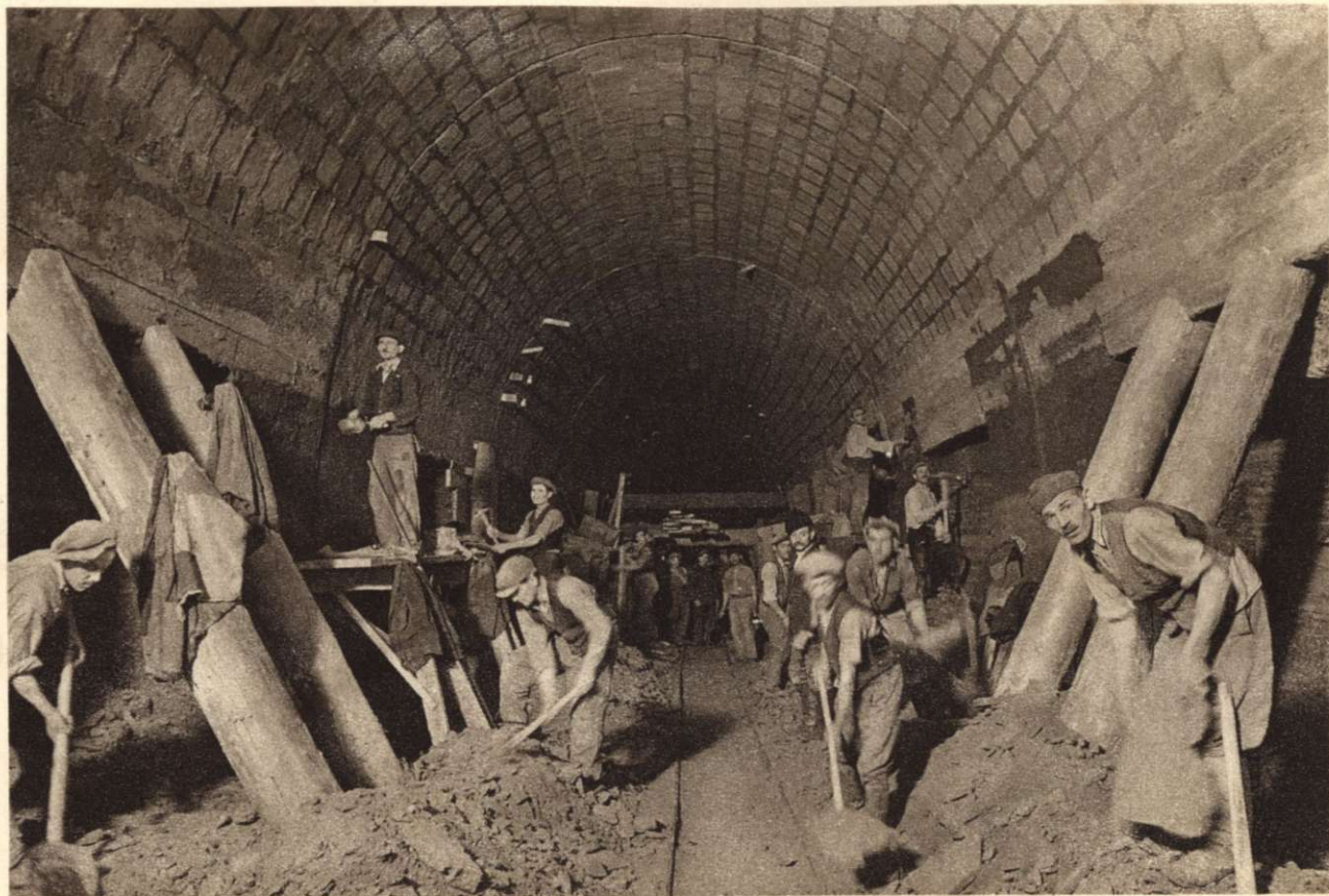
4. SZ. KÉP. KÉSZ ALAGÜTI BOLTOZAT ALÁFALAZÁSA A NAGYALAGÜTNÁL. 1942 FEBRUÁR.
