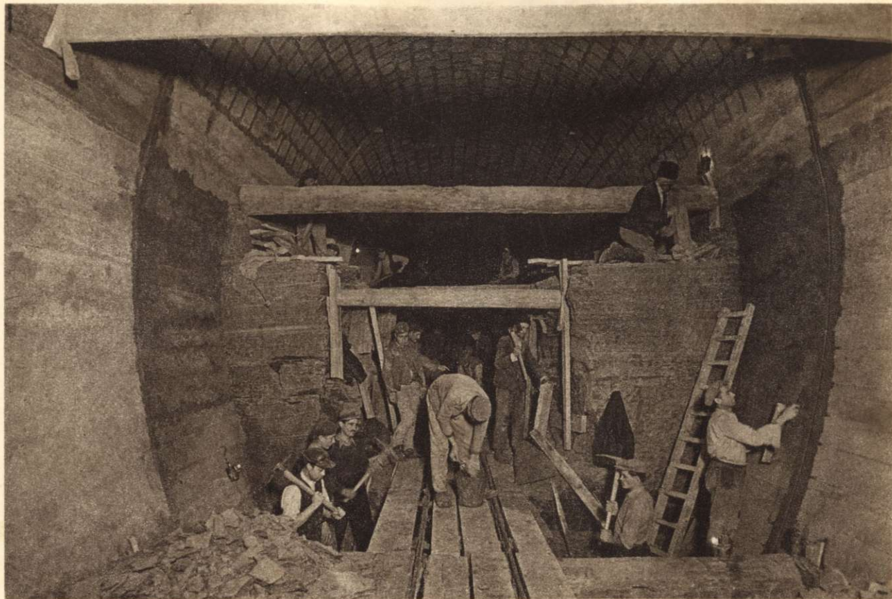
5. SZ. KÉP. FENÉKBOLTOZAT ÉPÍTÉSE A NAGYALAGÚT BELGA RENDSZERREL ÉPÜLŐ SZAKASZÁN. 1942 FEBRUÁR.
