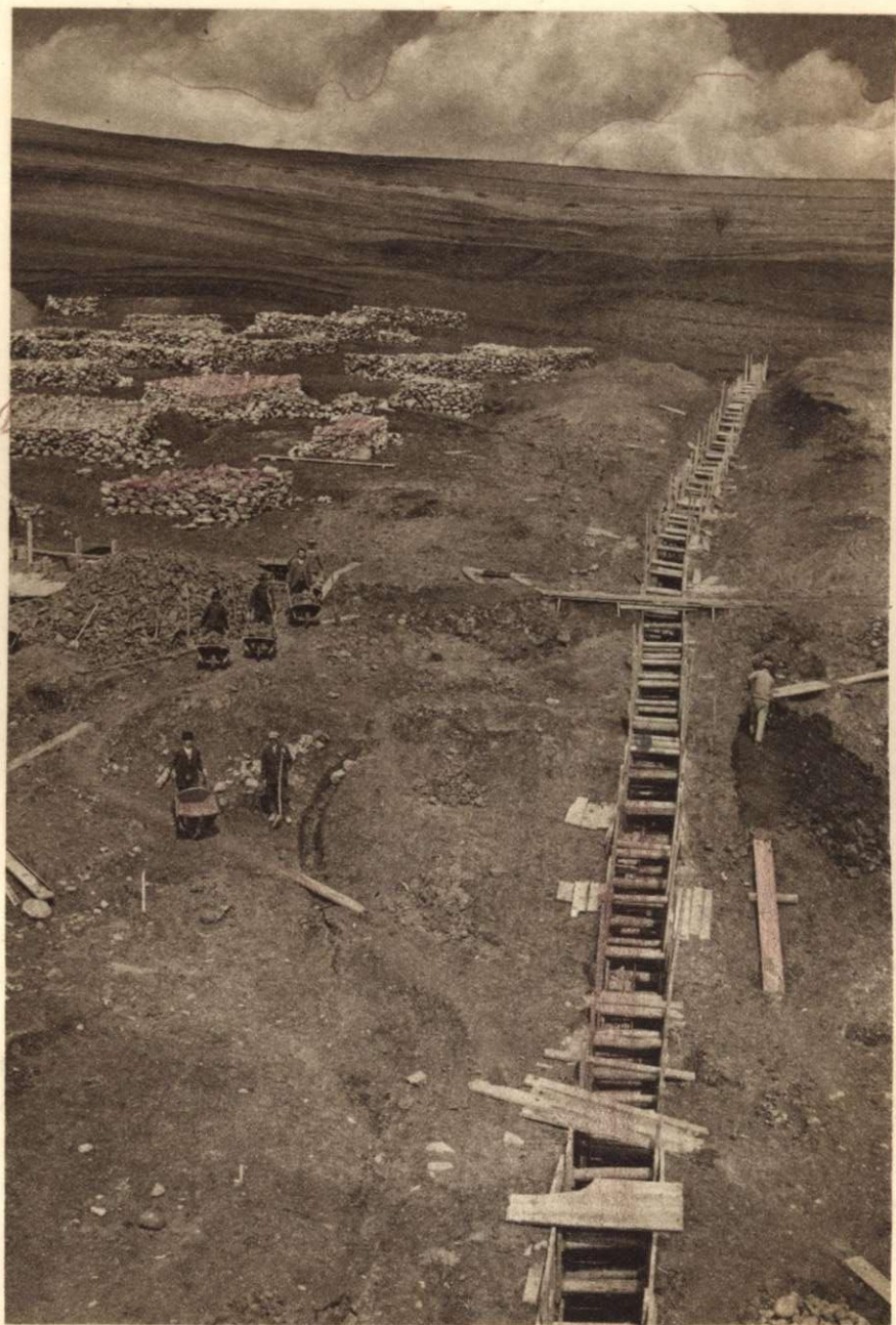
16. SZ. KÉP. ÖVSZIVÁRGÓ ÉPÍTÉSE A CSÜSZÓ ÉS FELGYŰRÖDŐ HEGYOLDALON. 1942 JÚNIUS
