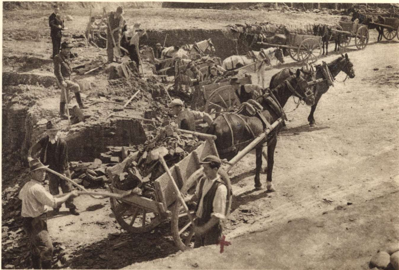
11. SZ. KÉP. BEVÁGÁS KITERMELÉSE KORDÉLLYAL. 1942 JÚNIUS.
