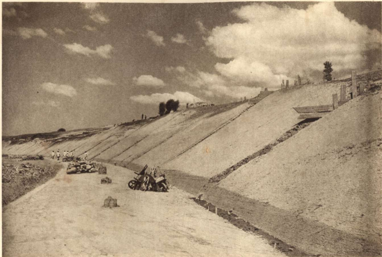
21. SZ. KÉP. ALSÓRÉPA ÁLLOMÁS ELŐTTI BEVÁGÁSRÉZSŰ SZÁRÍTÓSZIVÁRGÓI. 387/390. szelv. 1942 JÚLIUS.
