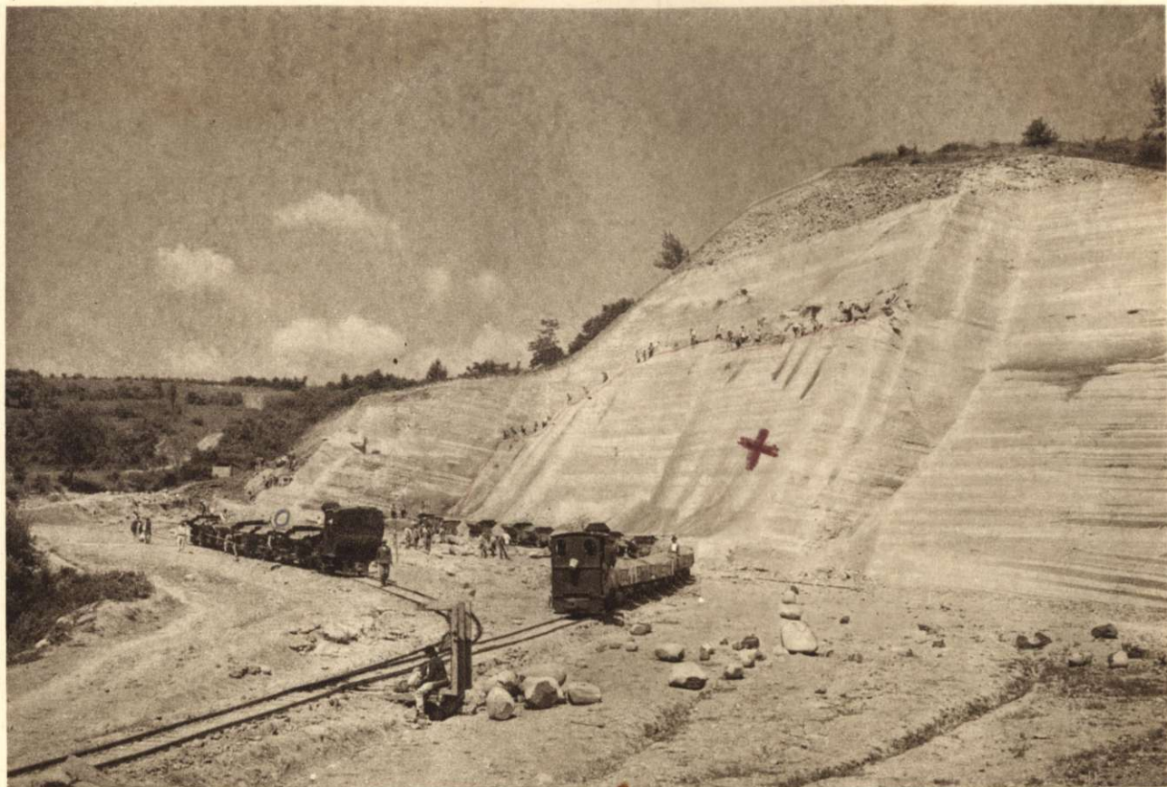
14. SZ. KÉP. HEGYLEHORDÁS DÉDA ÁLLOMÁS FELTÖLTÉSÉHEZ. 1942 JÚNIUS.
