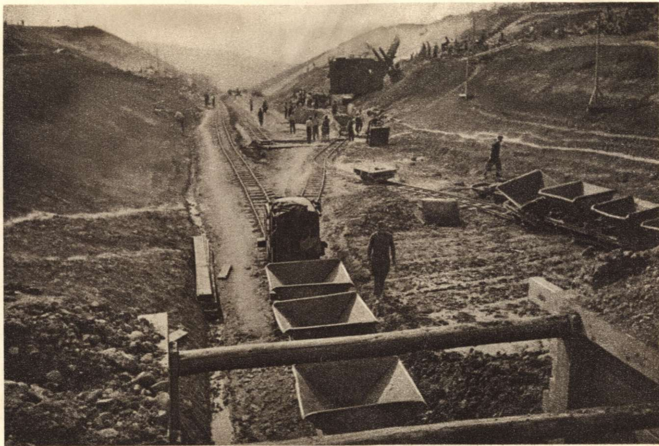
25. SZ. KÉP. RÉPAI BEVÁGÁS KITERMELÉSE KANALAS KOTRÓVAL. 380/383. szelv. 1942 AUGUSZTUS
