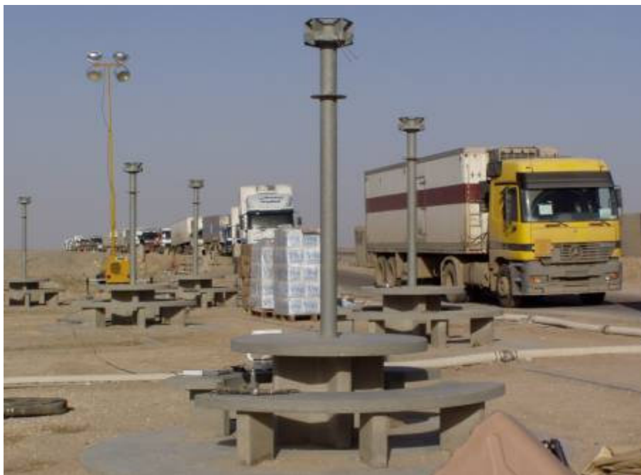
Nagykapacitású üzemanyag feltöltő pont. Egyszerre harminc csatlakozással
