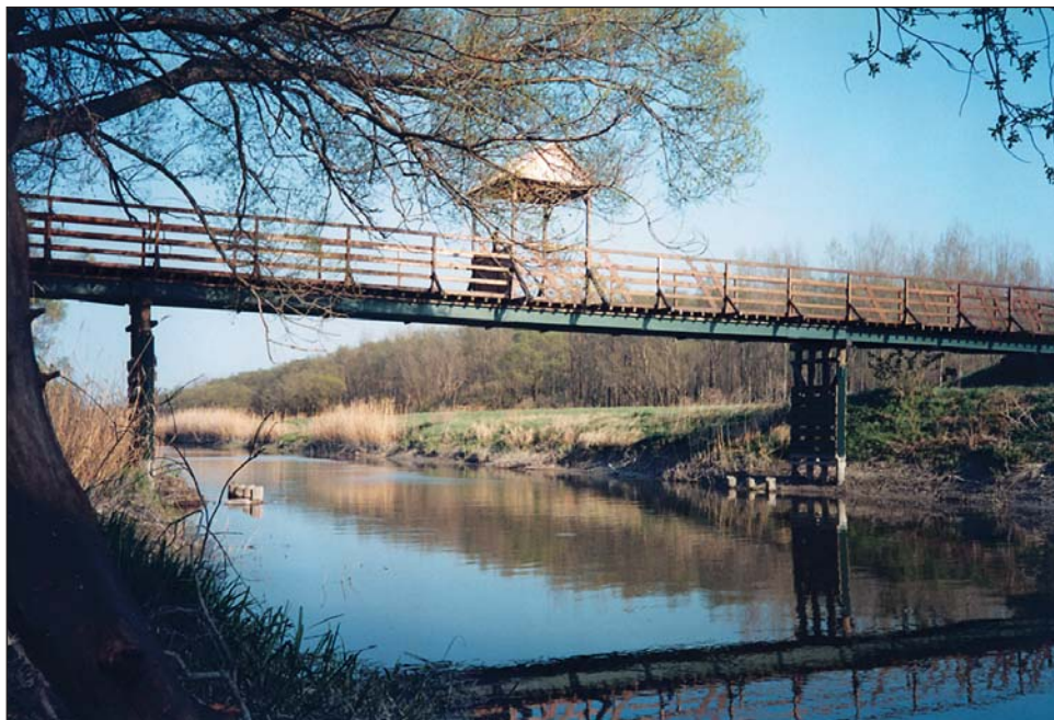
A HÍD ANDAUNÁL. ÁTÉRTÜNK
