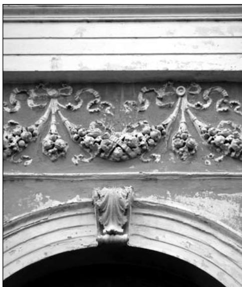
5. Épületplasztikai részletek a főhomlokzat emeleti ablakzónájában
