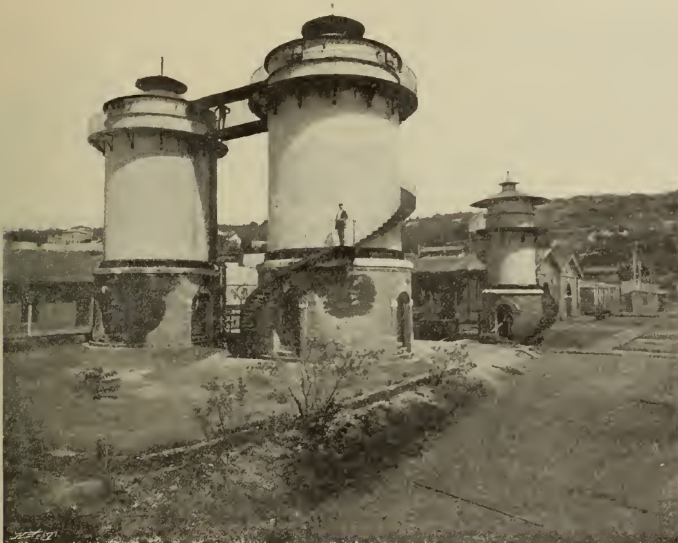
A FIUMEI KŐLAJFINOMÍTÓ TARTÁLYAI.
