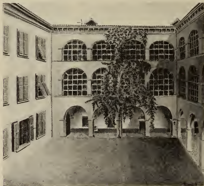
FIUME. — A GIMNÁZIUM. (UDVARI HOMLOKZATA).
