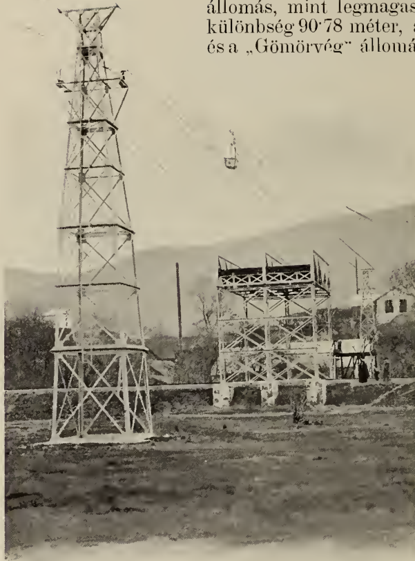
RÉSZLET A „CONCORDIA” VASGYÁR BÁNYATÁRSULAT SODRONYPÁLYÁJÁBÓL.
