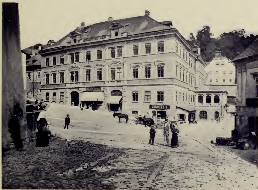
Selmeczbánya. — A bányászati és erdészeti főiskola épületei.
