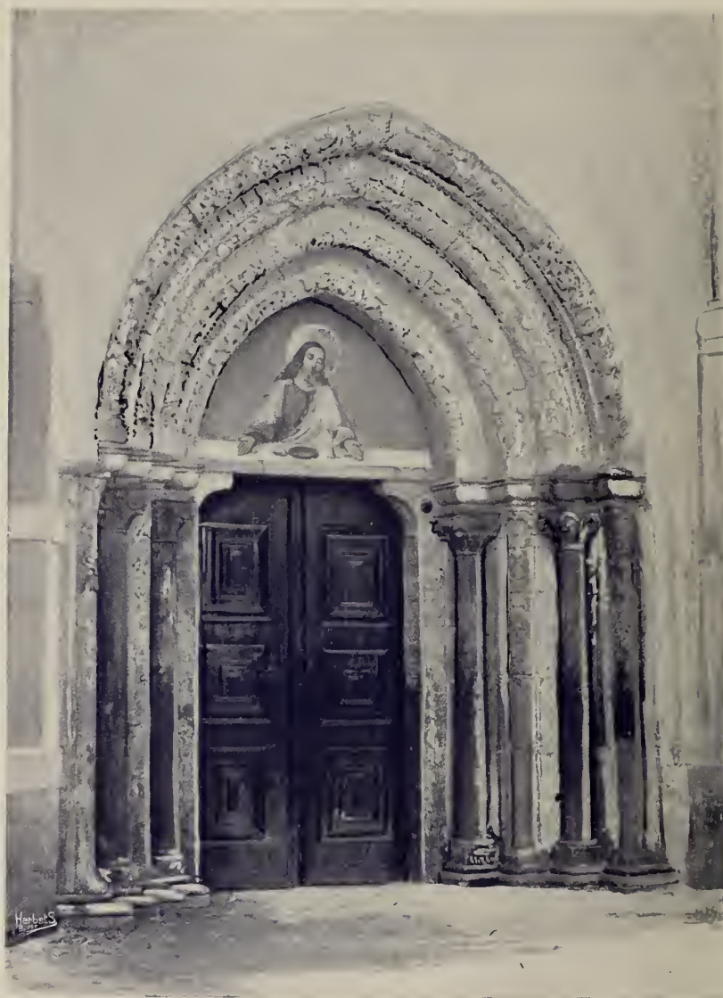
Az ipolysági plébánia-templom portáléja.
