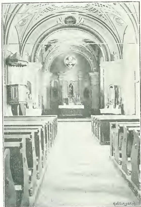
A CSALAI TEMELŐM BELSŐJE.
