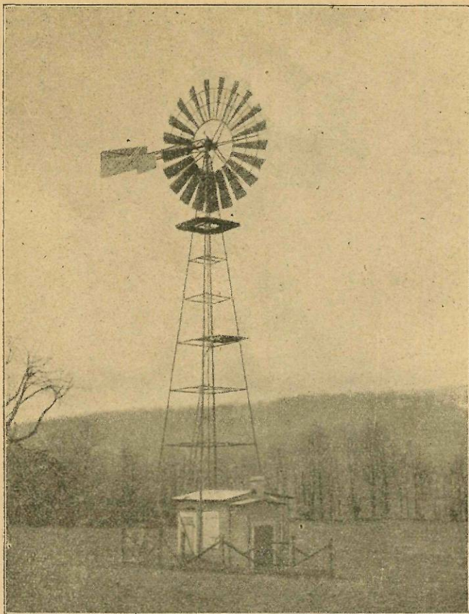
11. ábra. Burghessler község (Thüringien) vízvezetékének szélmotora.
