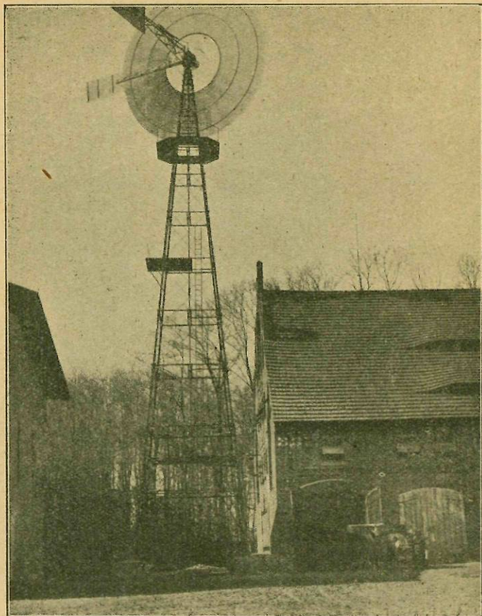
24. ábra. Szélmótoros villamosvilágítási, erőátviteli és takarmánykamra-berendezés Gross-Wurstróban (b. Alt-Gaarz, Mecklenburg). ☞
