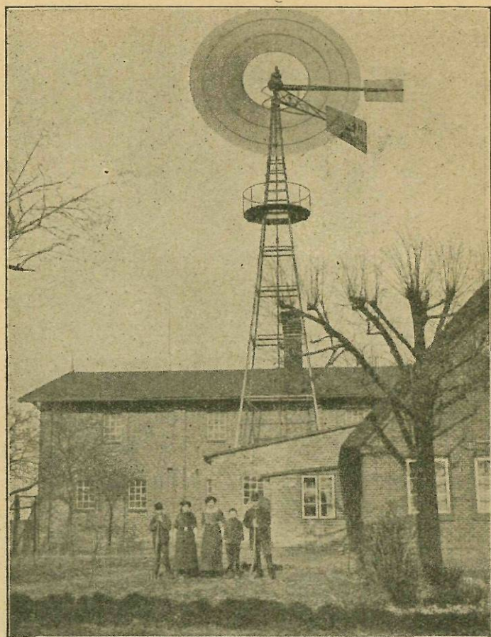
22. ábra. Szélmótoros villamosvilágítási és takarmánykamraberendezés Langeloheban (Schlesw.).
