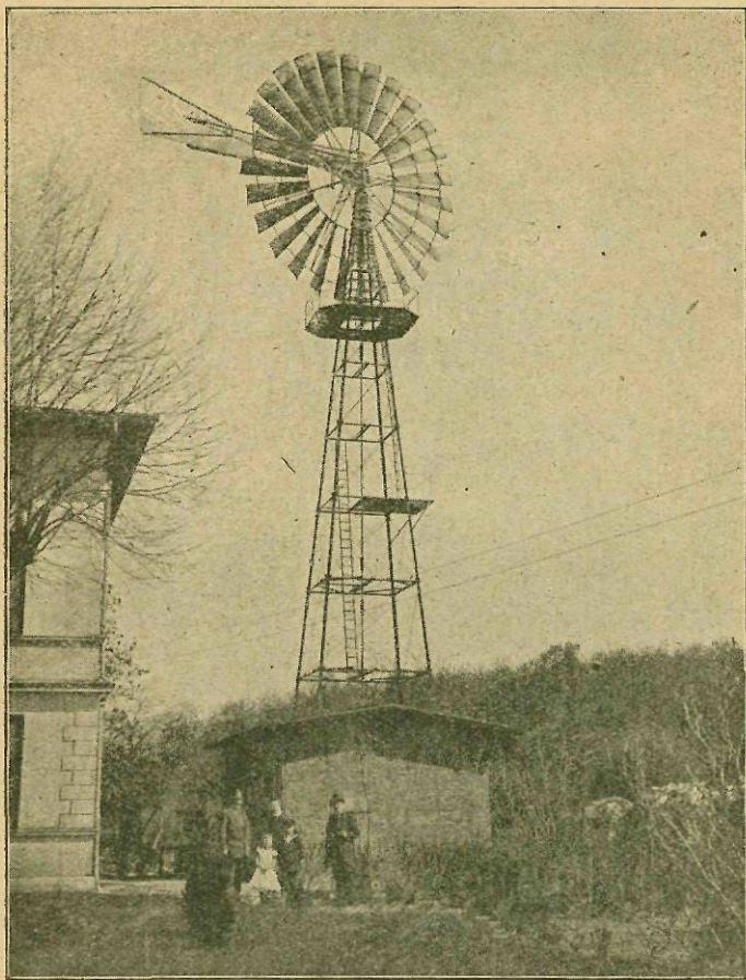
25. ábra. Szélmotoros villamos világítási és erőátviteli berendezés Ahrensboeckban (Schwerin).
