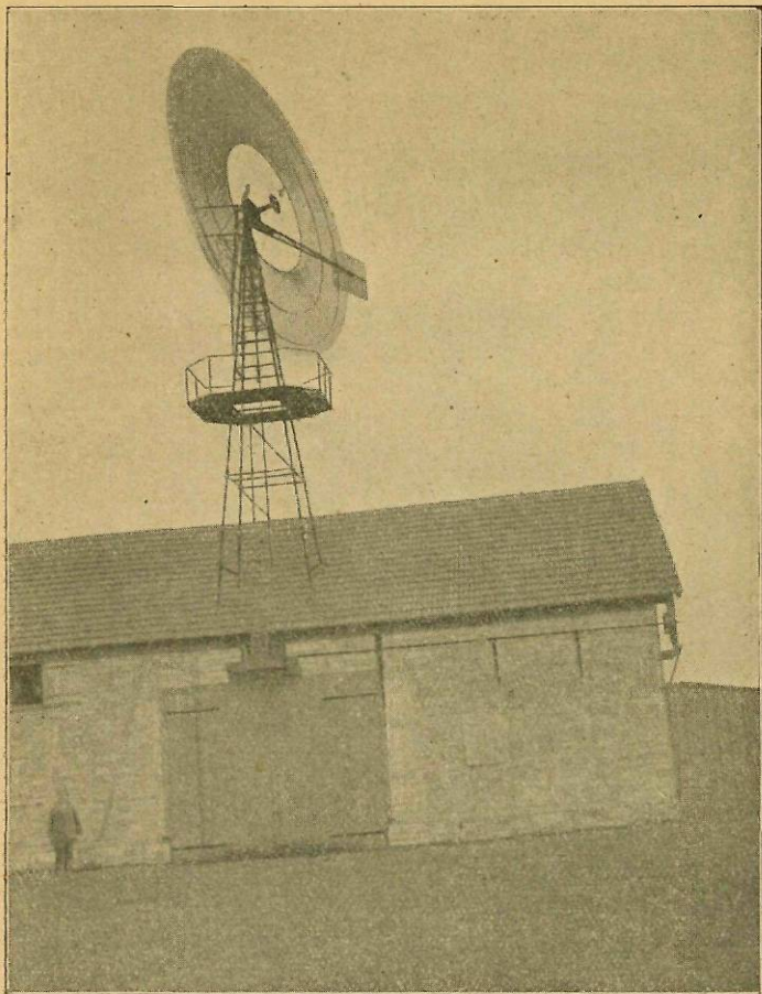
17. ábra. A szélmótoros takarmánykamraberendezés Rittersdorfban. A mellékvitorla szabályozása jól megfigyelhető.
