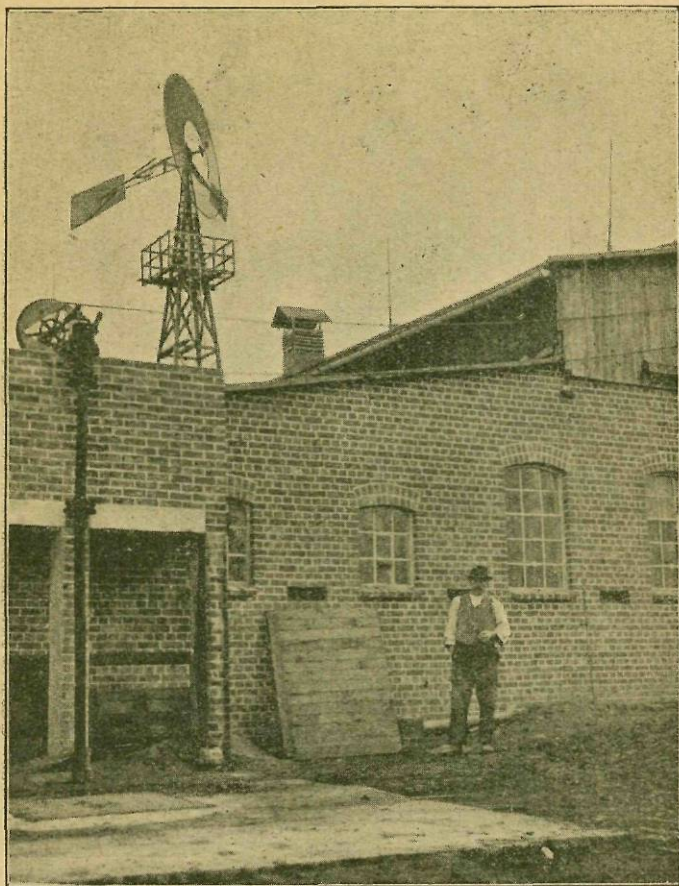
23. ábra. Szélmótoros villamosvilágítási, erőátviteli és takarmánykamra-berendezés Kurzenmoorban (Schlesw.).
