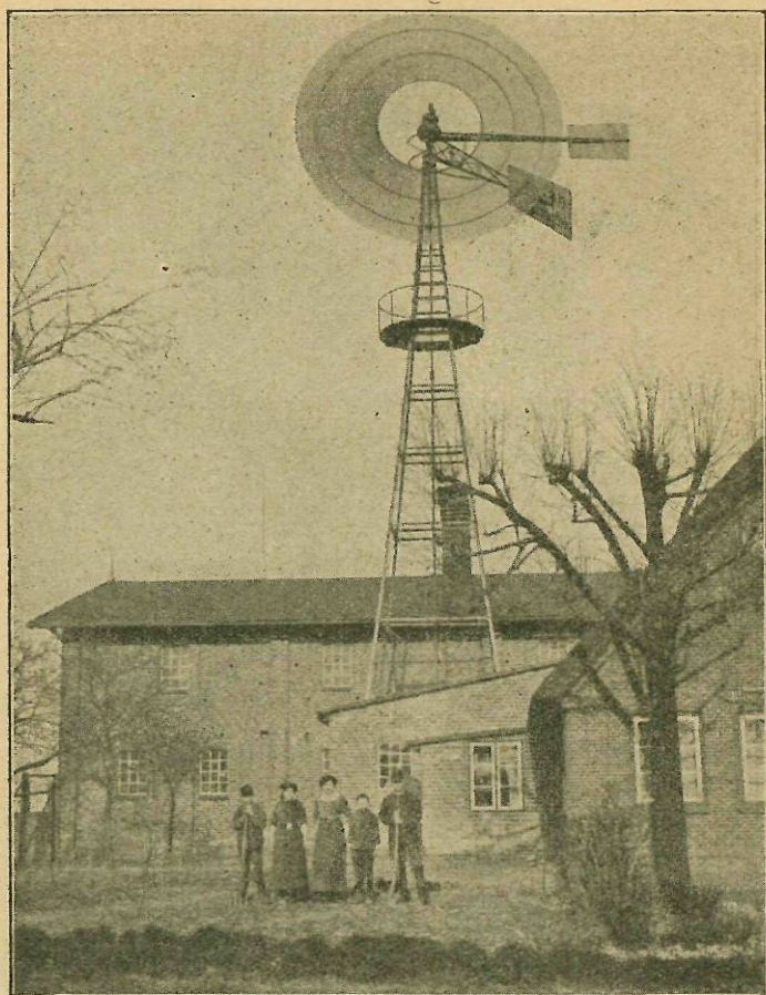
22. ábra. Szélmótoros villamosvilágítási és takarmánykamraberendezés Langelöheban (Schlesw.).
