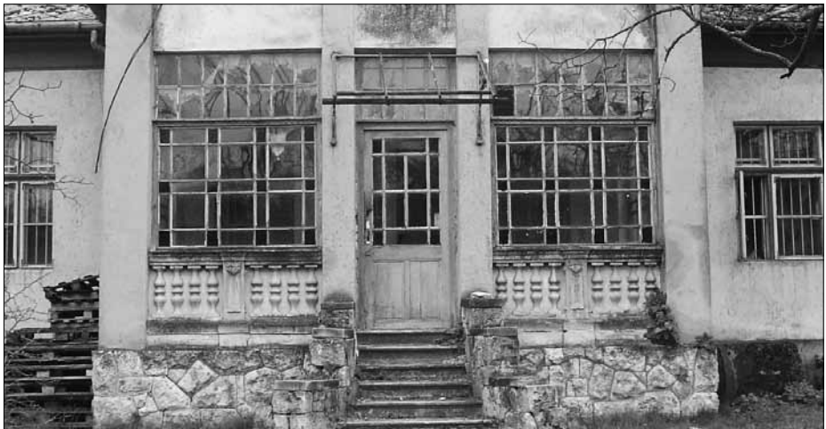
1912-ben a kor építészeti stílusának megfelelően előkerttel tervezték, széles macskaköves feljáróval, amire szinte rányit a felvezető lépcső.
