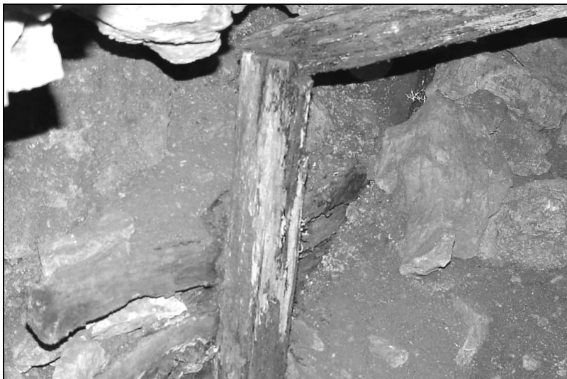
Fából készült biztosítás nyomai. (Fotó: Ondrej Rozložník.)
