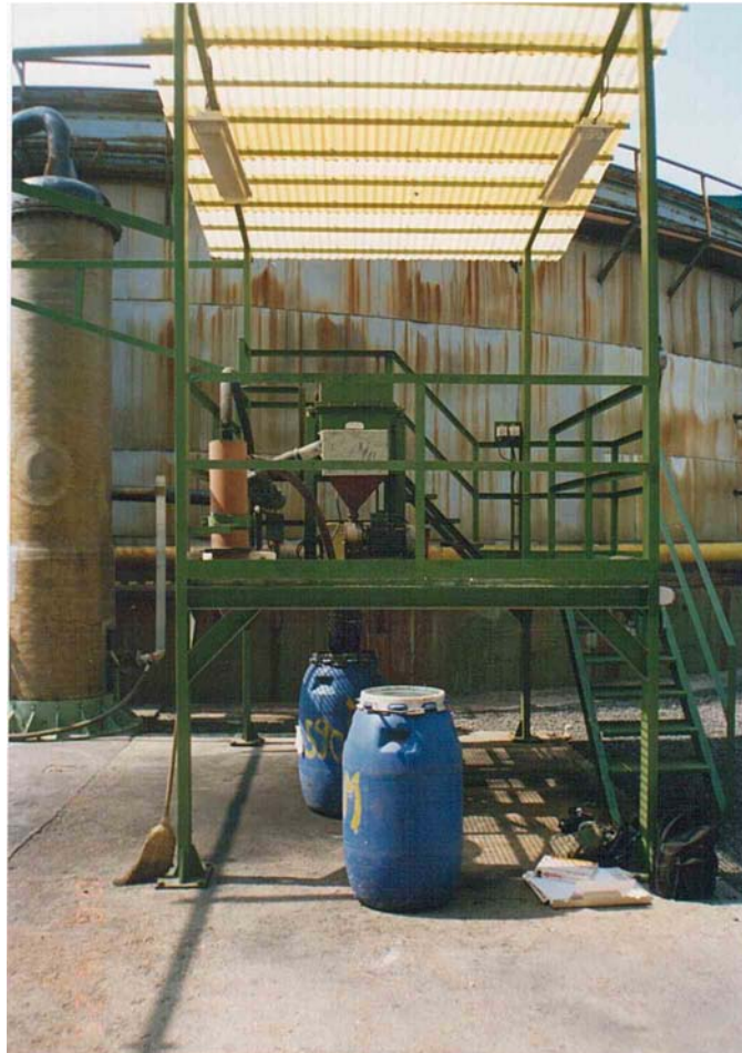
69.1 ábra Hg-os hulladék feldolgozó berendezés fogadó platform
