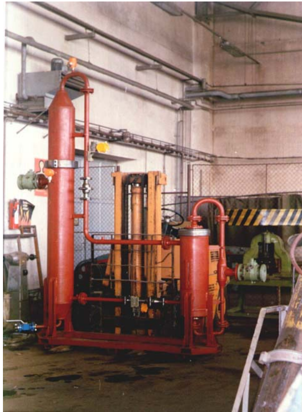
28.2 ábra Olajkúthozammérő szerelése (NME VAFK)
