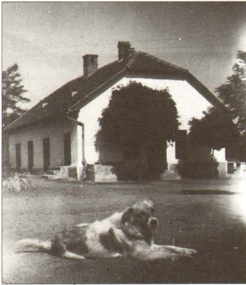
A Szekrényessy udvarház egyik legjelentősebb melléképülete, a mosóház.
