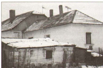
A tönkretett, kifosztott épület méltatlan állapotban várja sorsa jobbrafordulását.
