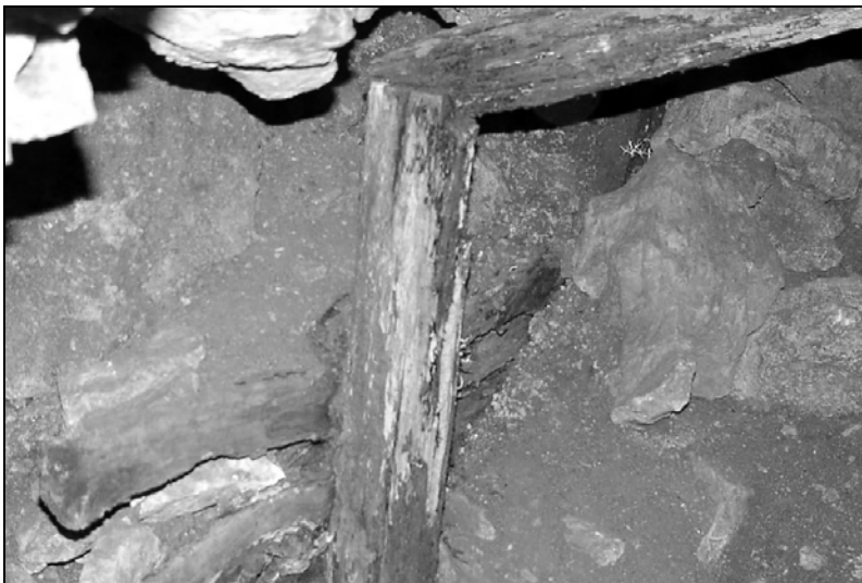
Zvyšky drevenej výstuže. (Foto: Rozložník Ondrej.)
