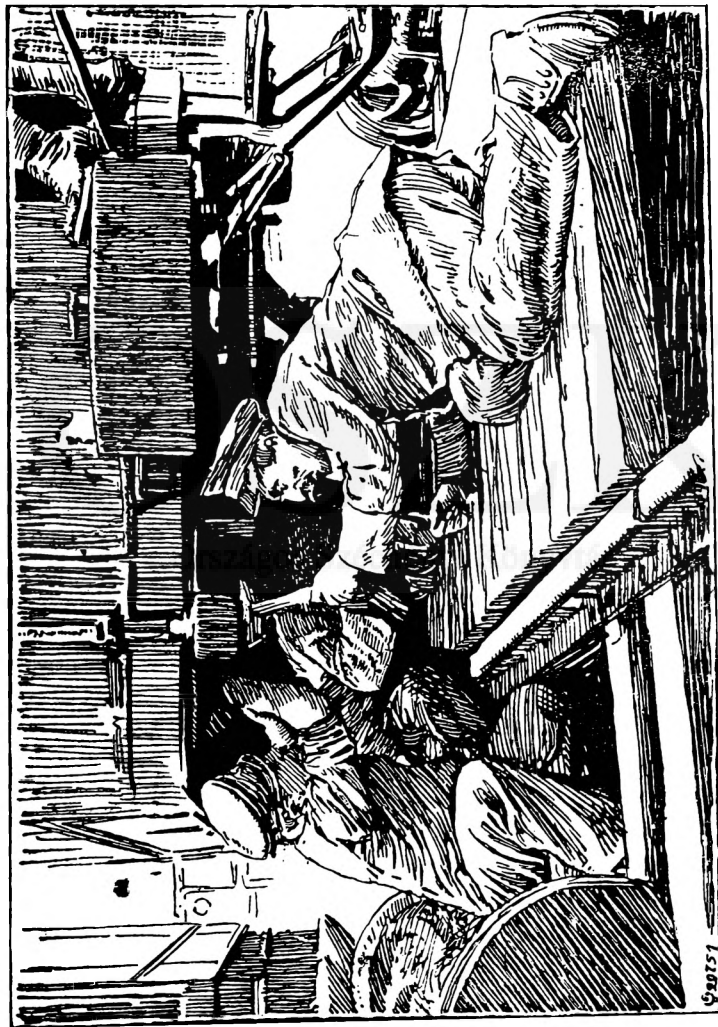
Az általunk meghódított Belgrádban a srapszelektől és gránátoktól felszakított villamos síneket iskolázott német katonák hozták helyre.
