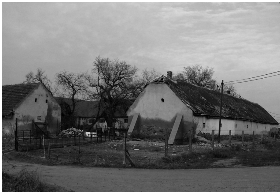
32. Nagyvenyim majorsági istállói. A nagyléptékű, hosszúkás tömbök négyzetes udvart fognak közre.
