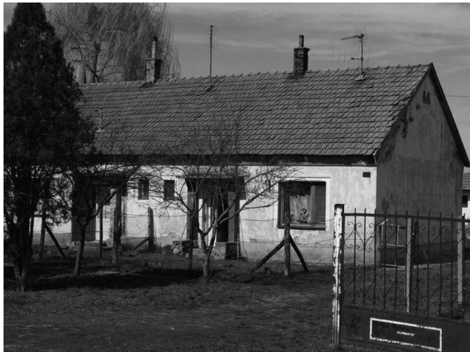
103. Munkáslakások a Lökösháza melletti Bréda-majorban az 1950-es évekből. Miközben a magánemberek számára megtiltották a külterületi építkezéseket, a TSZ központok és gépállomások munkaerő szükségletét biztosítandó az állam számtalan külterületi agrárlakótelepet hozott létre.
