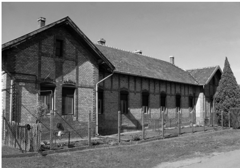
202. Vasutas típusház. A két világháború közötti építészetben még fontos szerepet kapott a díszítés, amit jelen esetben a téglasorok variálásával kívántak elérni.
