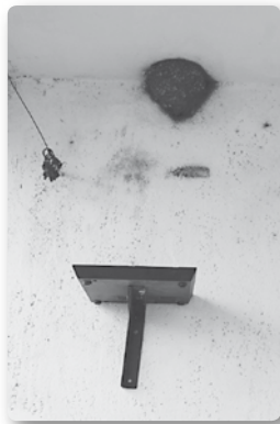
A fecskefészek alá szerelt ürülékfelfogó fecskepelenka sok veszekedést előzhet meg (Fotó: Orbán Zoltán)
