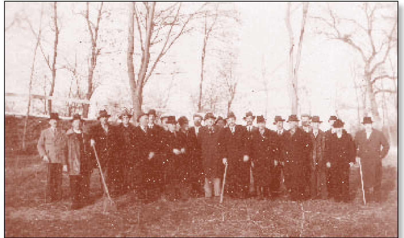
197-198. A fonyódi sportpálya építése
