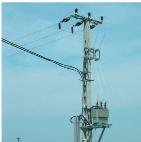
18. fotó: Oszlop transzformátor állomás (OTR) (Fotó: Demeter Iván).
