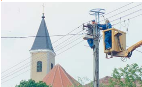
25. fotó: Gólyafészkek-magasító felhelyezése (Fotó: Lovászi Péter).
