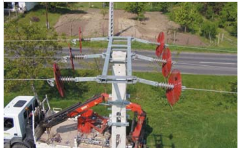
33. fotó: Terelőlemez szerelése feszítőoszlopra (Fotó: EDF-DÉMÁSZ).
