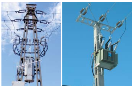
36-37. fotó: Tokozott, oszlopcsúcs alatt elhelyezett távvezérelt oszlopkapcsoló és belső biztosítás OTR állomás (Fotó:EDF-DÉMÁSZ).
