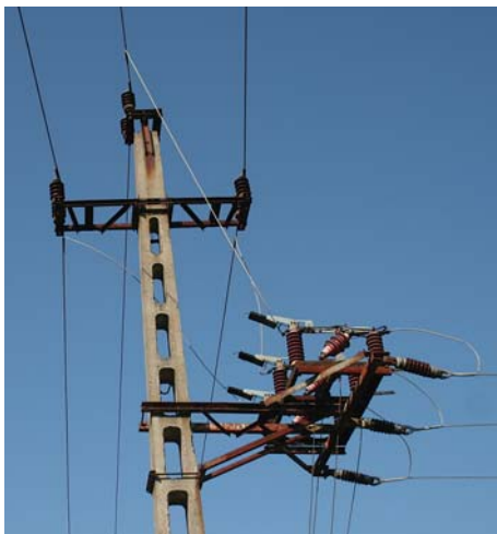
9. fotó: Példa egy összetett fejszerkezetű oszlopra: a tartó-fejszerkezet alatt egy vezetékleágazás van oszlopkapcsolóval (Fotó: Balázs István).
