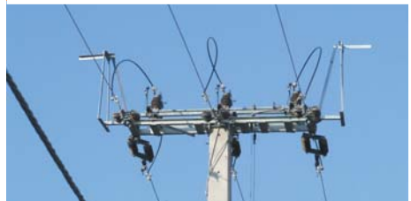
34. fotó: Madarak számára létesített kiülöhely oszlopkapcsolón (Fotó: EDF-DÉMÁSZ).
