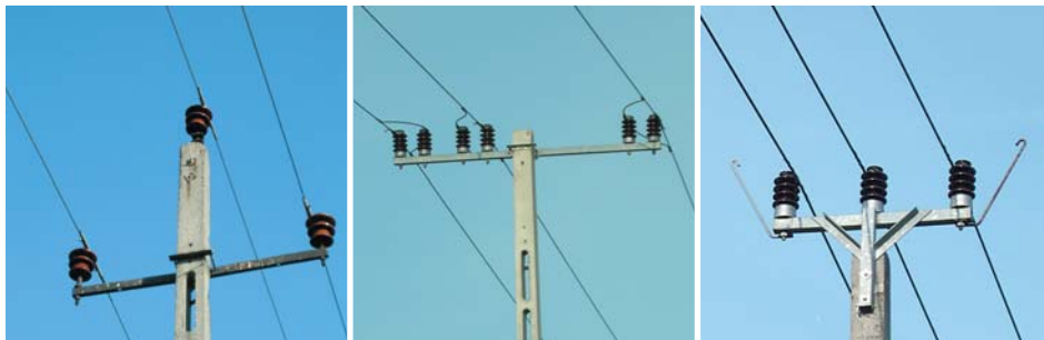
11-13. fotó: Tartóoszlopok: (11) háromszög vezetőelrendezés (ez a leggyakoribb szerkezet); (12) egysíkú vezetőelrendezés ketős felfüggesztéssel; (13) egysíkú, szűkített vezetőelrendezés leesés-gátolóval (Fotó: Demeter Iván).
