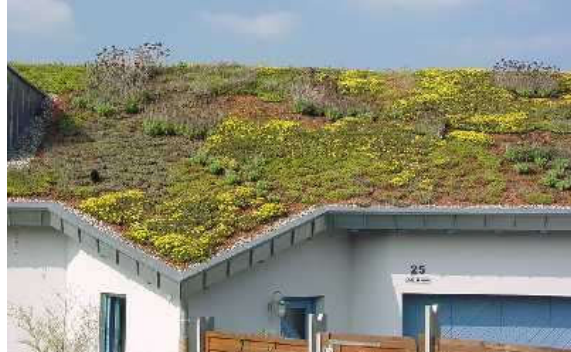
Zöld nyeregtető, Neuenstadt, Németország ( http://www.dachgaertner.de )
