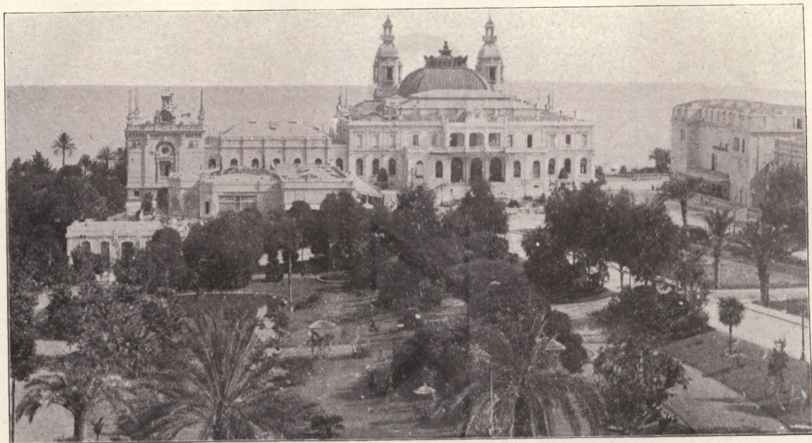
A CASINO RÉGIBB (1890-es évekből való) HOMLOKZATA.
