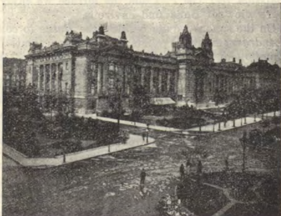
A Tőzsde-palota. Börsenpalast. Le palais de la Bourse. Il palazzo della Borsa. The Palace of the Exchange.
