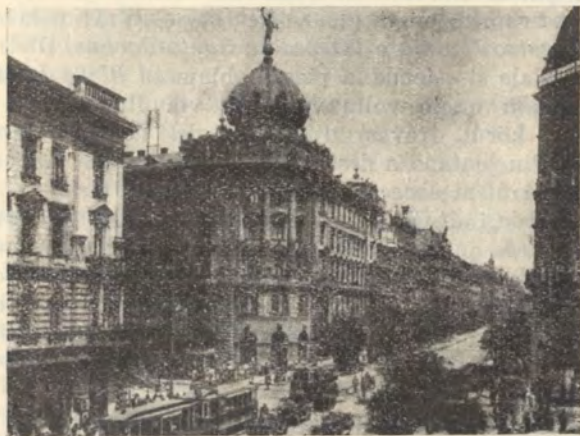
Pesti Hazai Takarékpénztár épülete a Rákóczi-út és a Körút kereszteződésénél. Das Gebäude der Pester Vaterländischen Sparkasse. L'Edifice de la Caisse d'Epargne de la Patrie sur l'Avenue Rákóczi.
