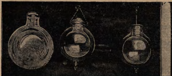
A cseppfolyós levegő eltartására való kettős falu üvegek.
