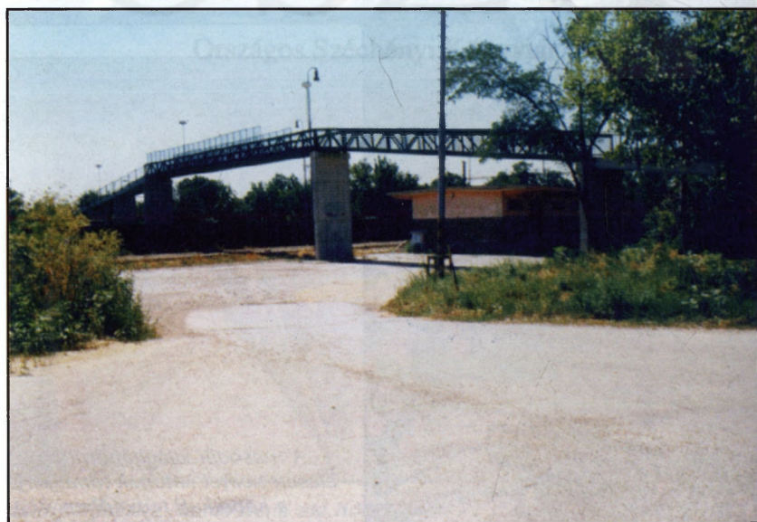
A vasúti felüljáró befejezés után
