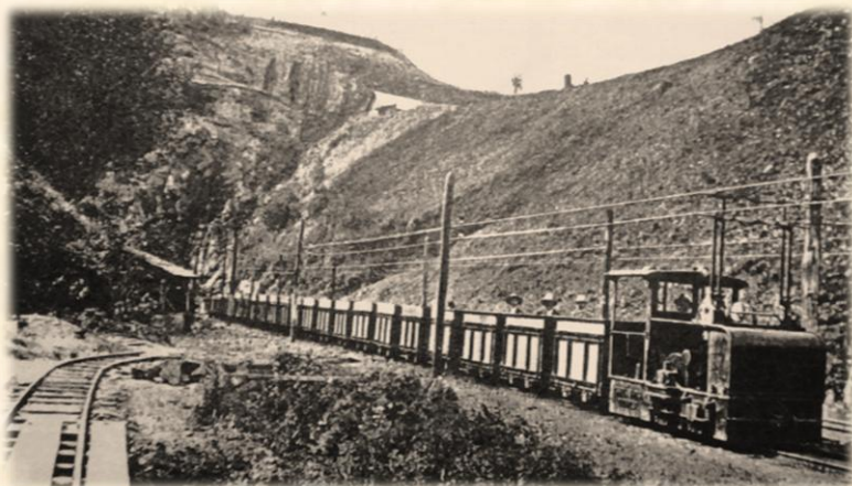
Vajdahunyd – Gyalár vasércbánya. 8,85 kW, háromfázisú Ganz bányamozdony, 300 V/42 Hz
