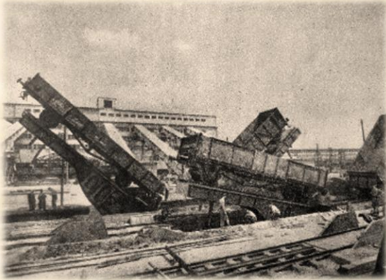
Szénosztályozói „érkező” vágánysor, vagonbuktatók szerelése 132
