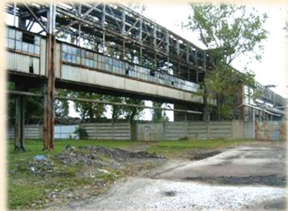
Szénosztályozó-erőmű szállítószalaghíd, valamint a gőz és melegvíz vezetékek tartórendszere 135
