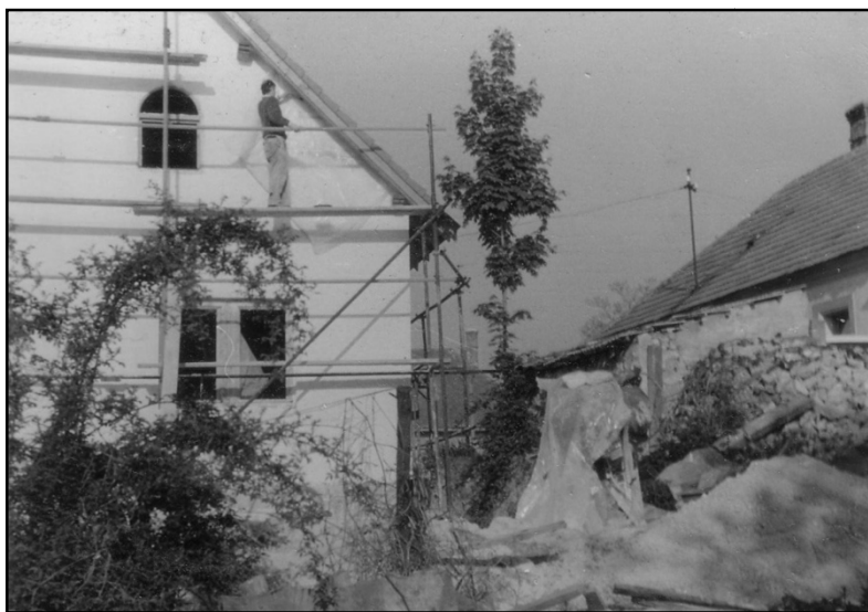
Az épülő nagy ház
