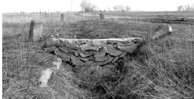
Vízlevezető árok feletti híd (négy sarkán kerékvető kövek)
