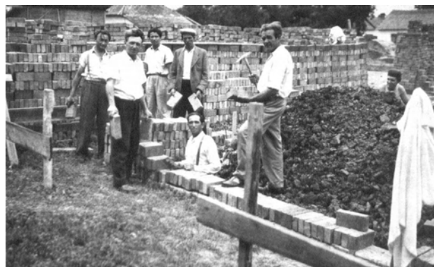
A gyógyszertár építési munkálatai (1959)
