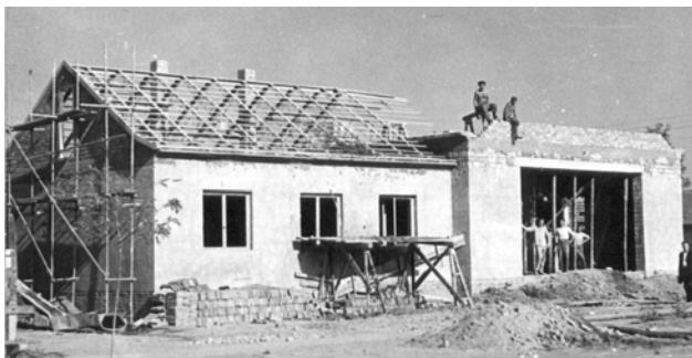
Az épülő Pártház...
