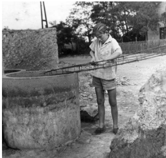
Vasbeton-kerítésoszlop vasvázát szerelem
