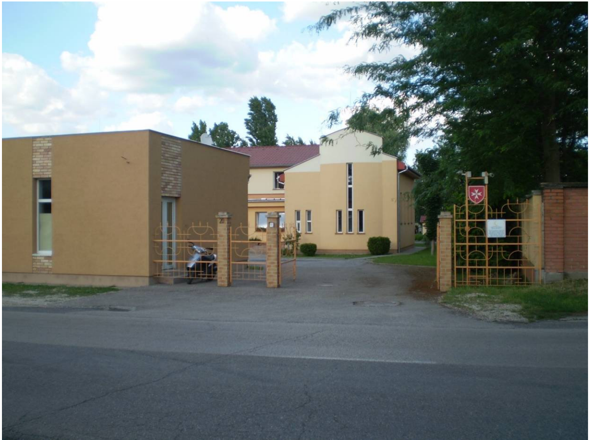
A Máltai Szeretetszolgálat Komplex Hajléktalanellátó és Rehabilitációs Központja
