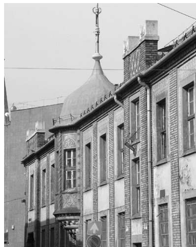
A Posta homlokzata a Mátyás Lajos utca felől
