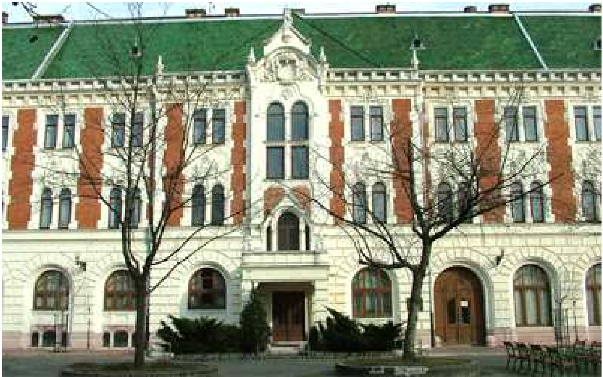
A Városháza homlokzata a Trombita tér felől
