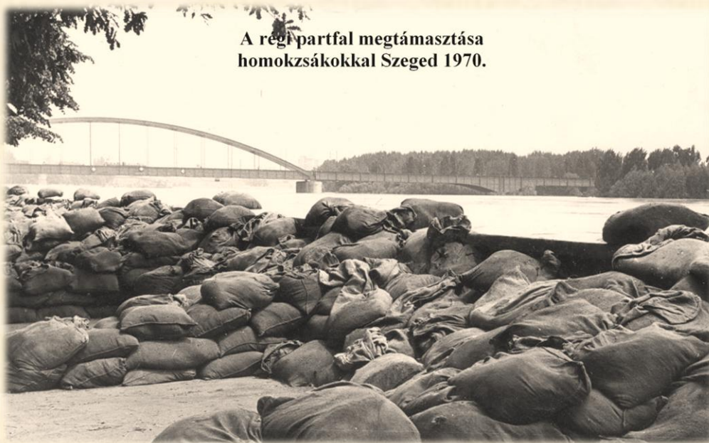
Amikor már a híd alatt ismét „átfért” a víz. A téglafal alaposan megerősítve.
