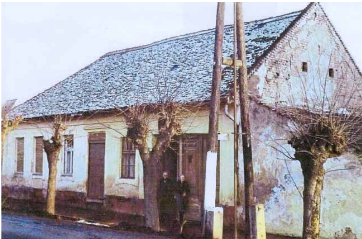
Az Örvös család ősi családi háza (Fő u. 58.), a féltetős épületrészben volt a régi kovácsműhely. A kapuban Örvös Ferenc (1896–1980) és felesége, Mayer Mária. A ház helyén jelenleg a rendőrség épülete áll.
