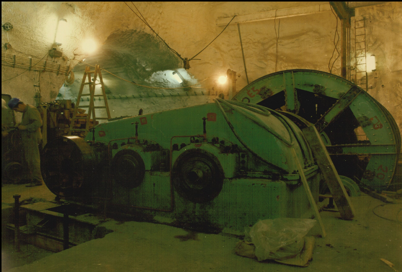
Vakaknai dobos szállítógép beépítés, csak a motor nincs a helyén. Előtérben a hajtómű, mögötte a dob. (4/13-as vakakna).
