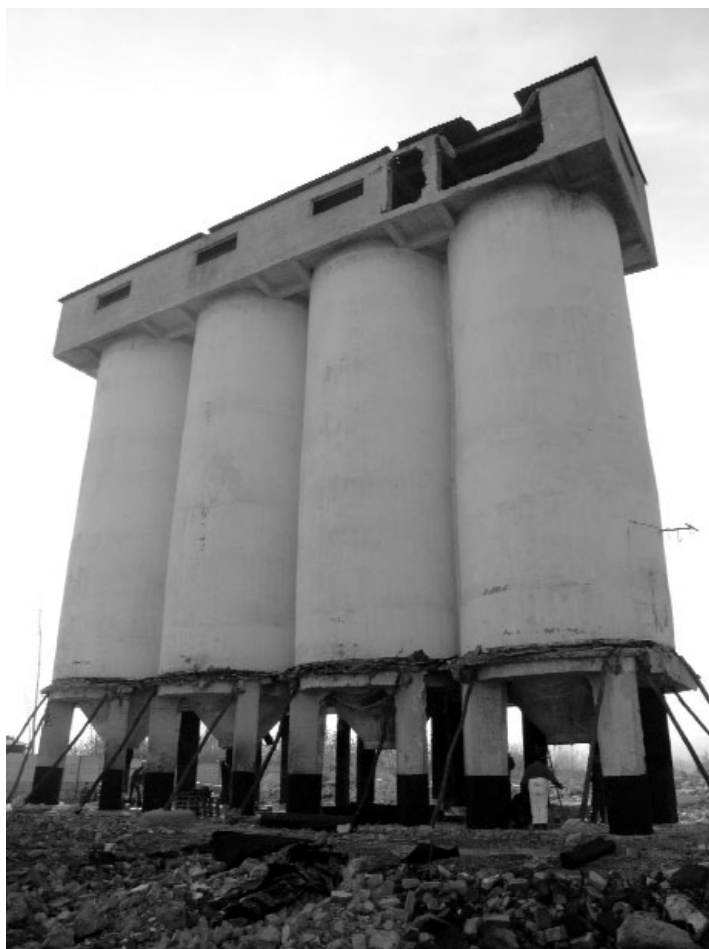
A Cementipari Gépjavító silóinak robbantásos bontása a miskolci Ávas lakótelep mellett
