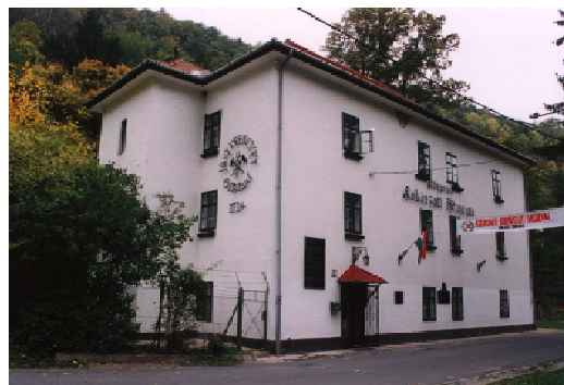
Felső-Hámor település kialakulása és a Kancellária épületének megépítése az 1770-es években
