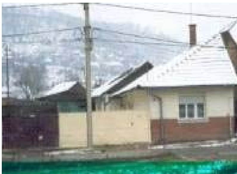
A Geró utcai lakás, amely a volt fodrász-helyiségből alakult ki, az ajtónak ablakra cserélésével
