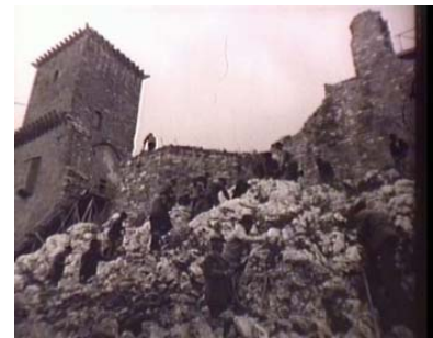
A Diósgyőri Vár rekonstrukciója elkezdése
