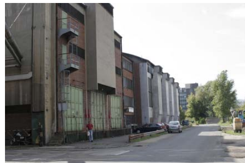
Kompresszor-gépház homlokzata Hasznosítható területe: 2x2.000 m 2
