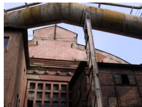
A Keleti-erőmű nyugati homlokzata Hasznosítható területe: 2x2.000 m 2
