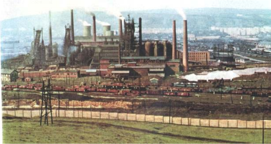
A nagyolvasztók déli oldalára lett telepítve az új Ércdarabosító-mű
