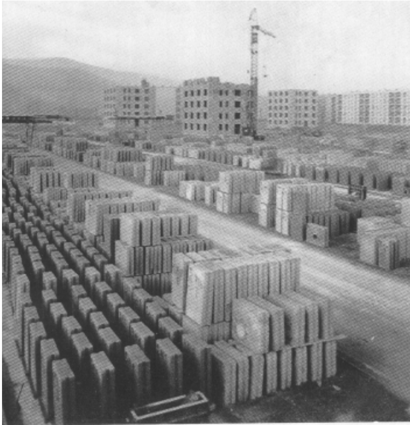
Habosított kohósalak- blokkok felhasználá- sával (az LKM nagyolvasztóinak melléktermékéből) épülő lakások Miskolcon, a Kilián- városrészben
