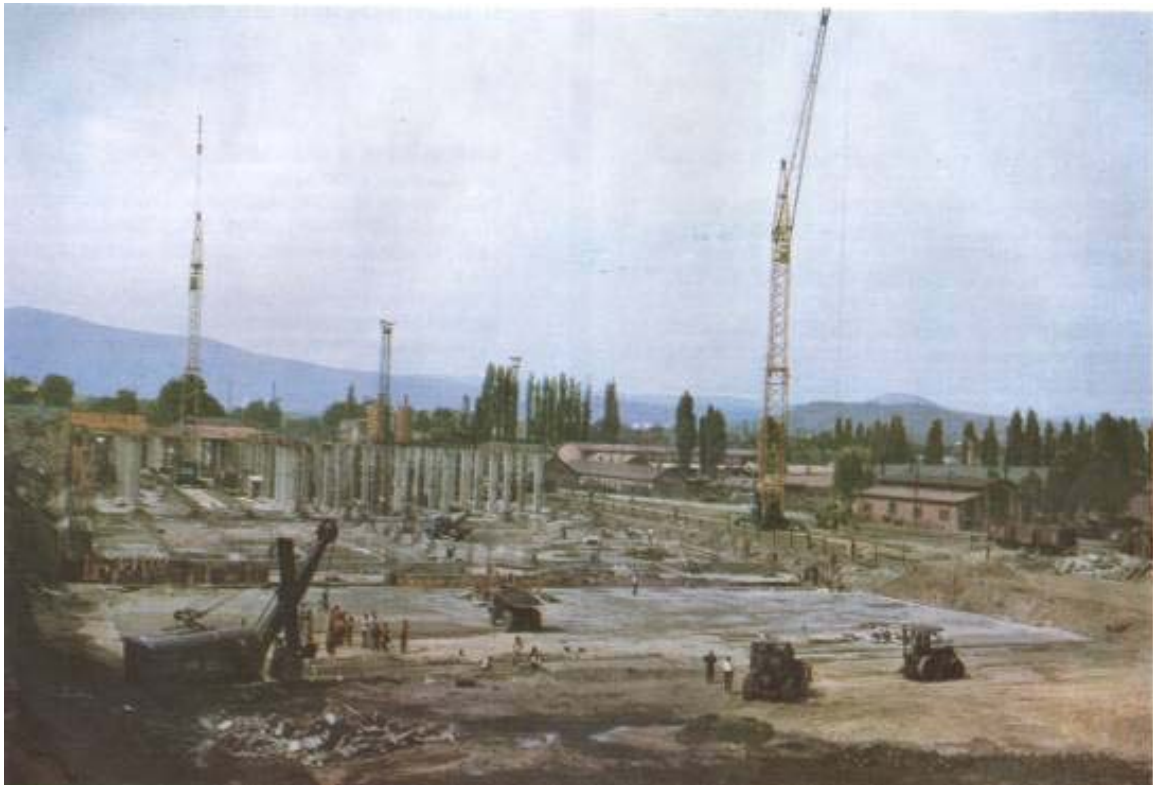
Nemesacél-hengermű építése 1973-ban
