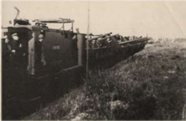
Olasz páncélvonat, TA.1 típus, 76 és 152 mm lövegekkel 61
