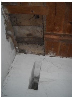
4. Kép: Ezen a résen fűzték át a transzmisszió laposíóját, a mennyezetet látni a felvonó helyét
