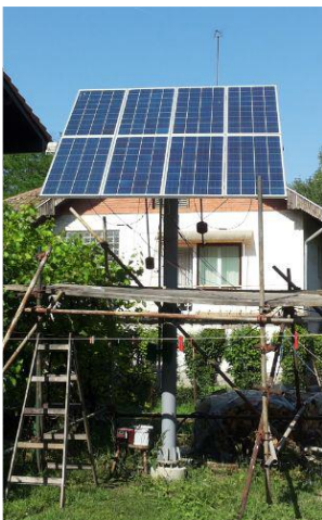
1. ábra: A Palicson összeszerelt napkövető napelem rendszer (bal oldal), a megépített adatgyűjtő állomás (jobb oldal). Forrás: saját kép
