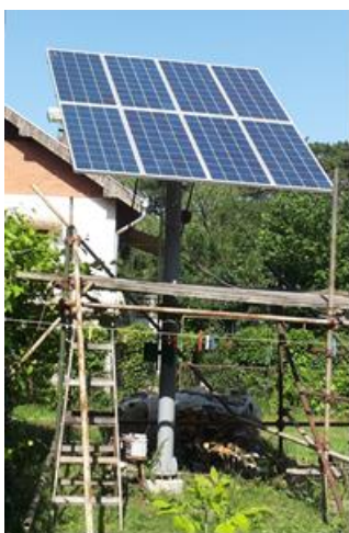
10. ábra: A nap követő napelem rendszer (bal oldalt) és az állvány orientáció változtatásának lehetőségei (jobb ábra). Forrás: saját ábra
