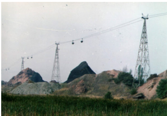
Az Edelény I-IV. akna, és a berentei központi szénosztályozó közötti függőkötélpálya, alatta a régi meddőhányók.
