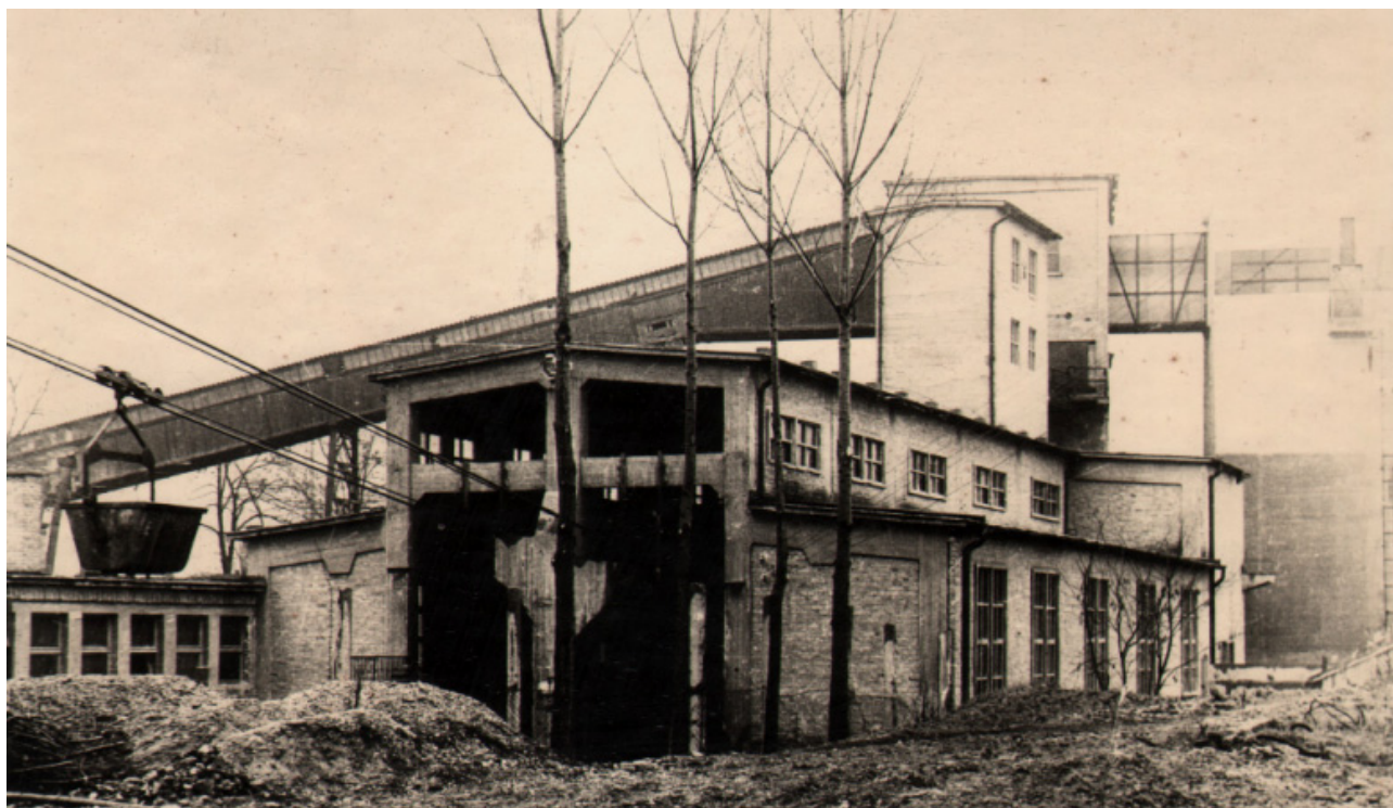
Az I-es akna függőkötélpálya feladó állomása. (Hargittay)
