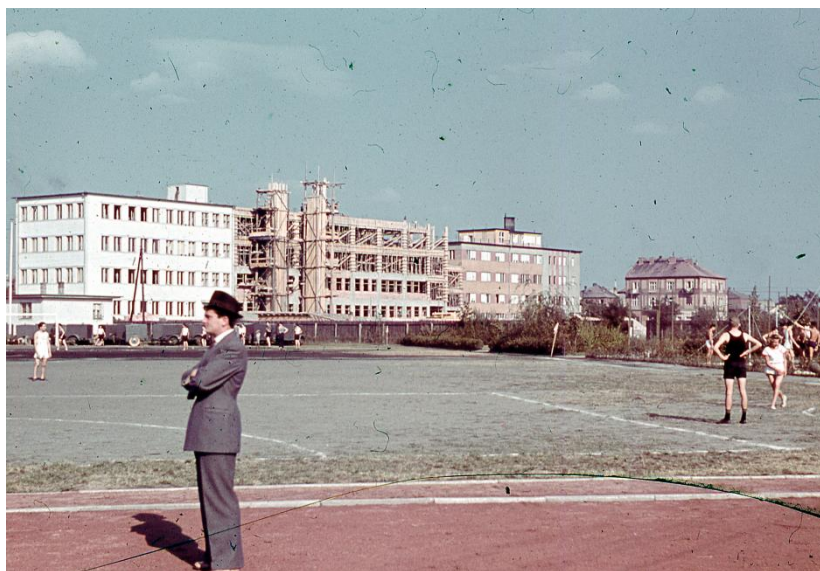
14-15. Gamma Rt. Fehérvári úti építkezések (1939)
