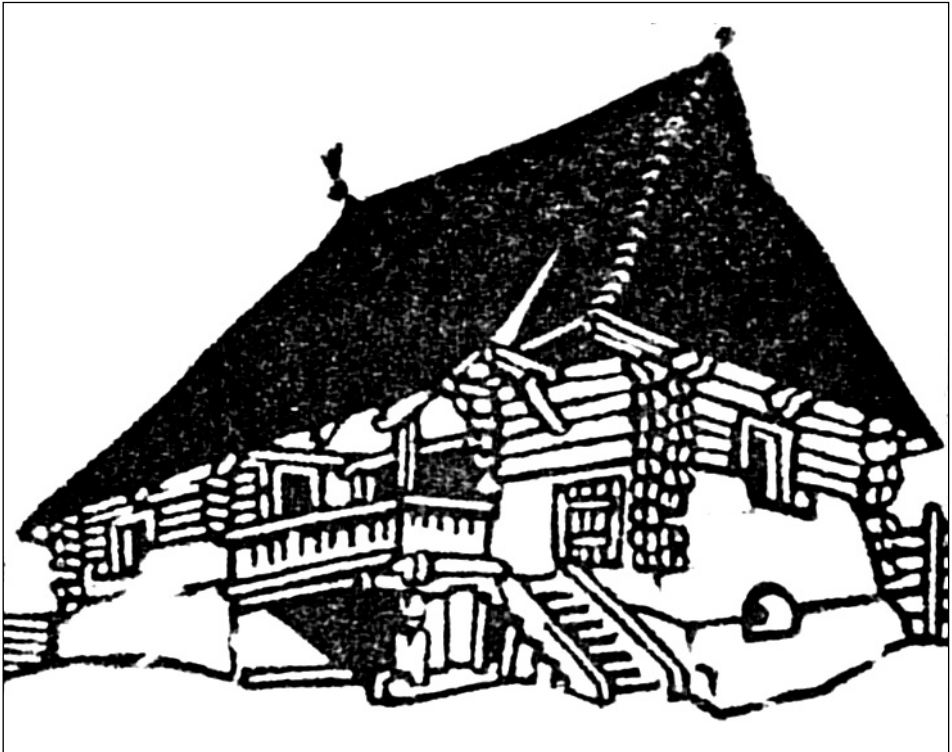
11. ábra. A századforduló nemzedéke számára Torockó jellegzetes népi építészetét az ablakig vakolt boronaházak jelentették. Kós Károly rajza (közli Gergely 1998)
