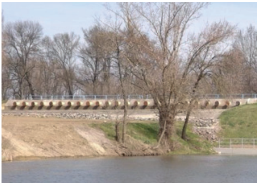
8. ábra. A Hortobágy-Berettyó árvízkapuval ellátott hajózható oldalcsatornája. Az árvízkaputól balra lévő 24 db acélcsővön keresztül emelik át a Hortobágy-Berettyó vizét a Hármas-Körösbe nagy árvizek alkalmával. (Fotó Tóth Cs.)
