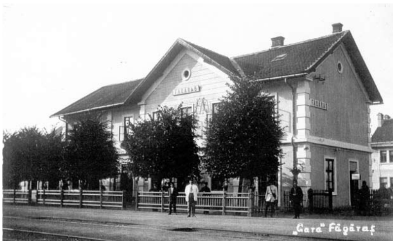
2. A fogarasi pályaudvar épülete
