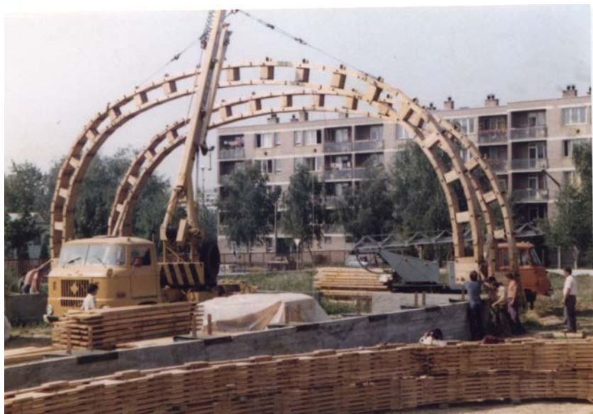
Az épülő vívóterem
