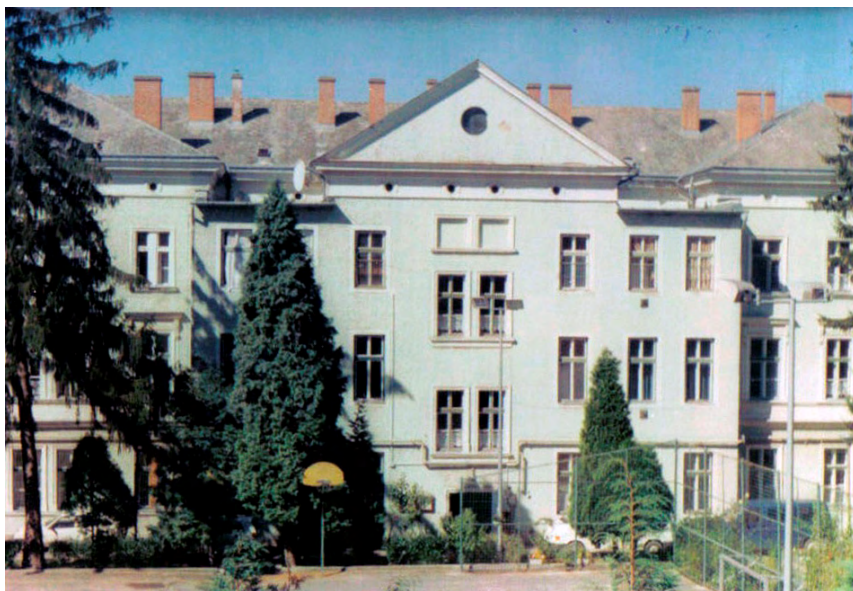
A volt kollégium az udvar felől 2006-ban
