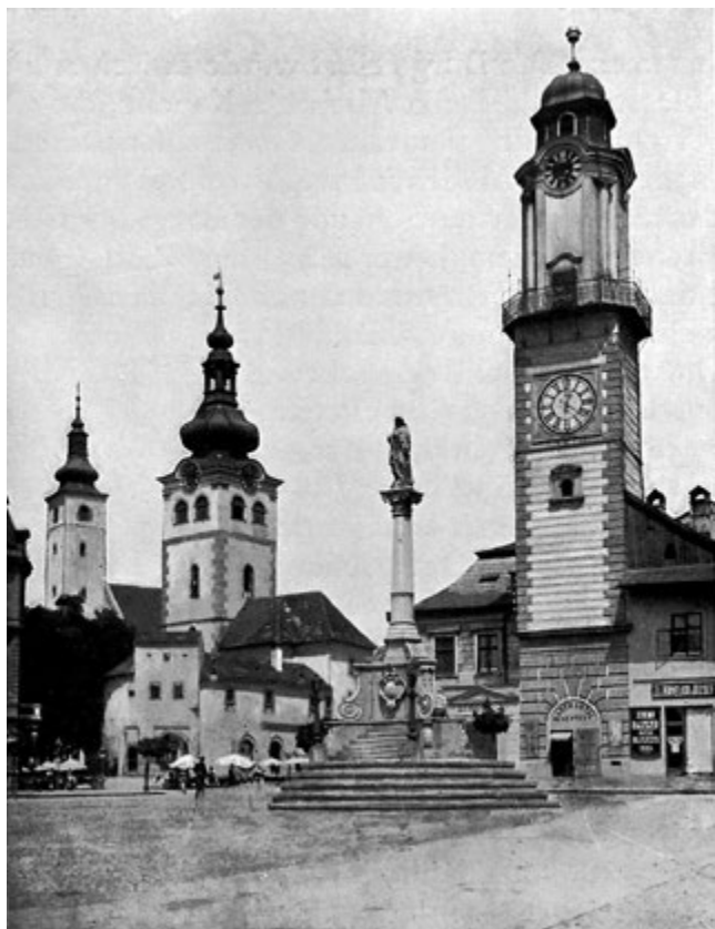
A besztercebányai óratorony 1900 körül. A tűzfigyelésre és riasztásra készült négyszögletes tornyot 1552-ben építették, a körfolyosó 1665-ből, a barokk stílusú kupola pedig 1784-ből származik
